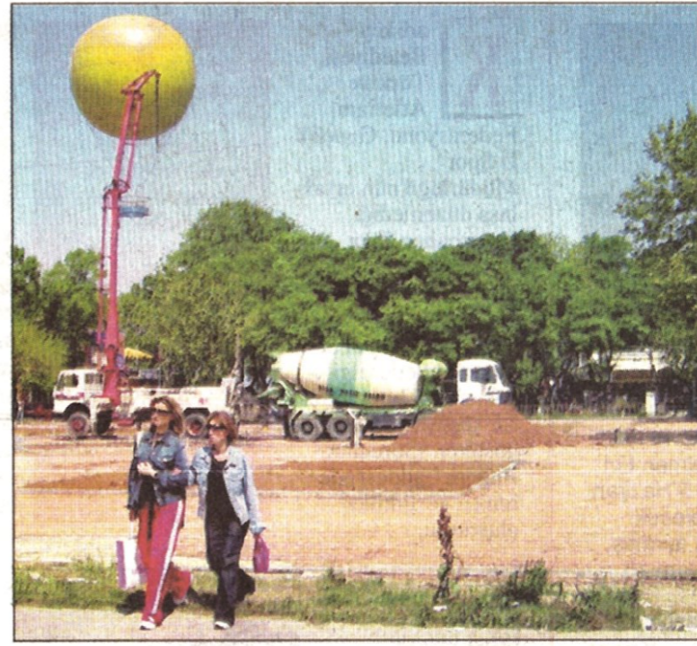
İnönü Parkı, çalışma nedeniyle şu an kullanılamaz durumda
